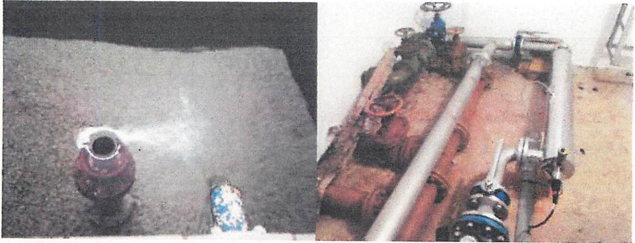
**Abbildung 1: links: Aufbereitung mit Jurakalken, rechts: UV-Filteranlage**
